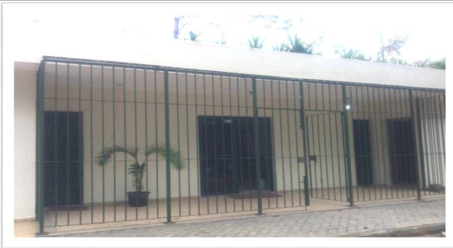
Figura 2- Entrada principal reformada
