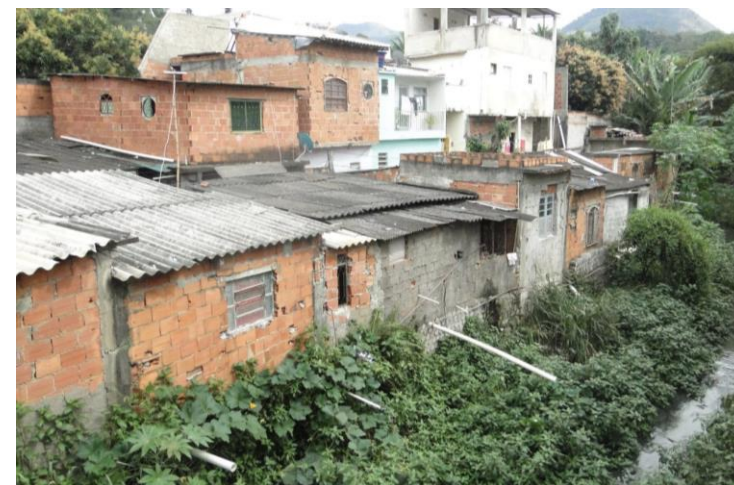
Figura 22 – Ocupações Irregulares na Calha do Rio Pequeno.
